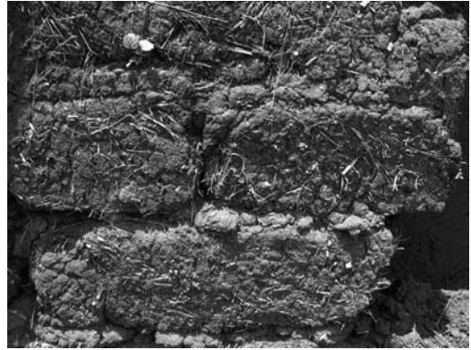
Figura 8 La hierba como agregado al adobe (Bühler 2013)
