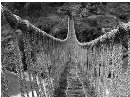
Figura 10 La base del puente se cubre de ramizas (Bühler 2013)
