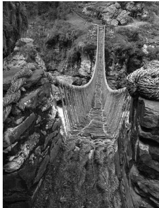
Figura 9 Las seis criznejas formando una catenaria (Bühler 2013)
