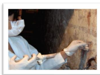
Figura 7 - Aplicación del mortero de inyección.
