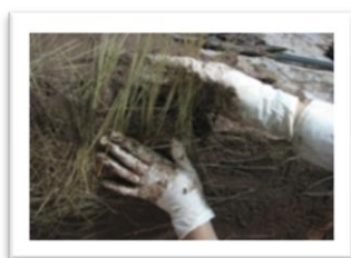
Figura 5 - Detalle de embarre o enfoscado en las zonas faltantes
