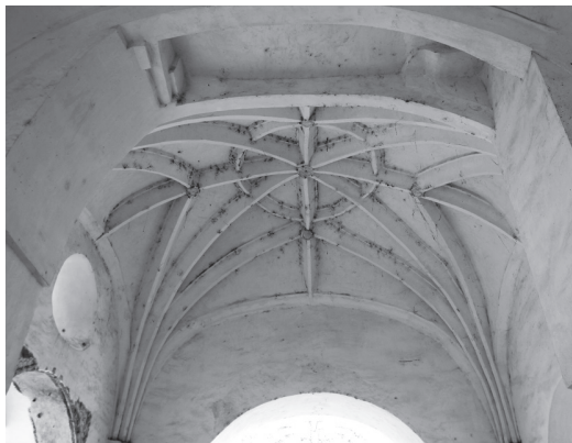
Figura 3 Perú, iglesia de San Agustín de Saña (1590-1630). Vista de la bóveda vaída de crucería estrellada con los nervios combados formando una circunferencia concéntrica a la clave central, situada en el primer tramo de la antigua capilla hornacina del Evangelio. (Sandra Negro y Samuel Amorós, 2015)
