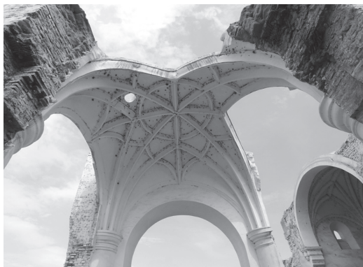
Figura 5 Perú, iglesia de San Agustín de Saña (1590-1630). Vista de la bóveda vaída de crucería en el tercer tramo de la antigua capilla hornacina del Evangelio, la cual repite en menor escala el diseño de doble estrella de la bóveda del coro. (Sandra Negro y Samuel Amorós, 2015)
