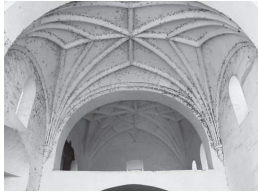
Figura 2 Perú, iglesia de San Agustín de Saña (1590-1630). Vista de las bóvedas vaídas de crucería del coro alto a los pies del templo, que se organiza en una doble estrella, y del primer tramo de la nave. (Sandra Negro y Samuel Amorós, 2015)
