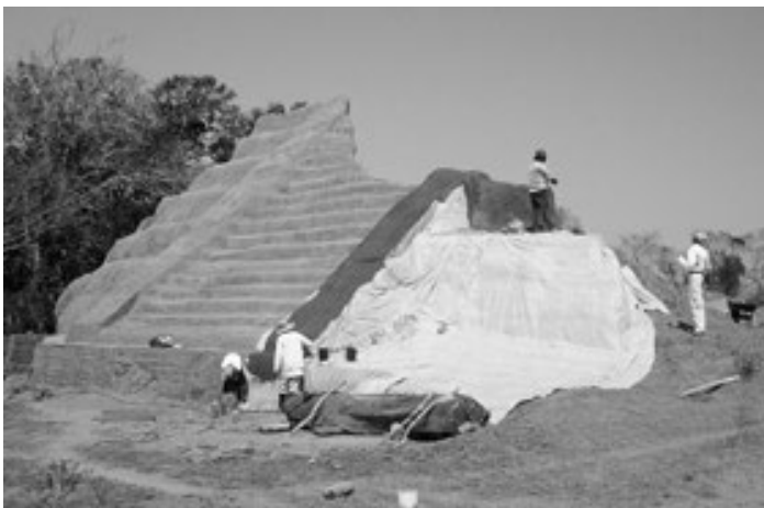
Figura 8: Colocación de un geotextil y recubrimientos de sacrificio sobre los restos de la fachada de la pirámide de La Joya, México.
