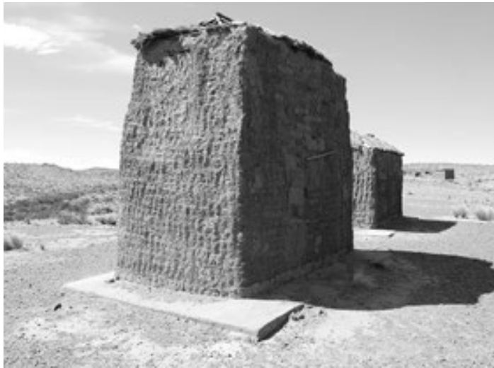
Figura 5: Uso de adobes y madera para reforzar los muros originales de paja-arcilla que caracterizan a las chullpas de Chacarilla, Bolivia.
