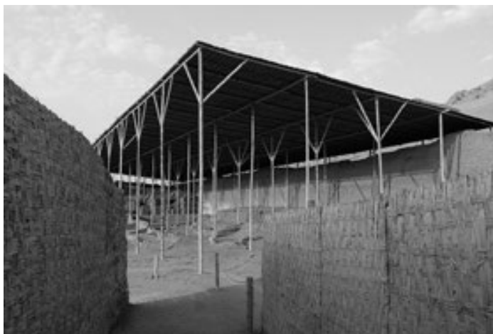
Figura 7: Uso de materiales tradicionales y barreras corta vientos en las Huacas de Moche, Perú. Fotografía: L. Guerrero
