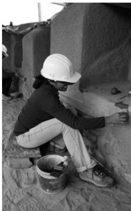
Figura 3: Restitución de revoques con barro en el Palacio Tschudi, Chan Chan, Perú.
