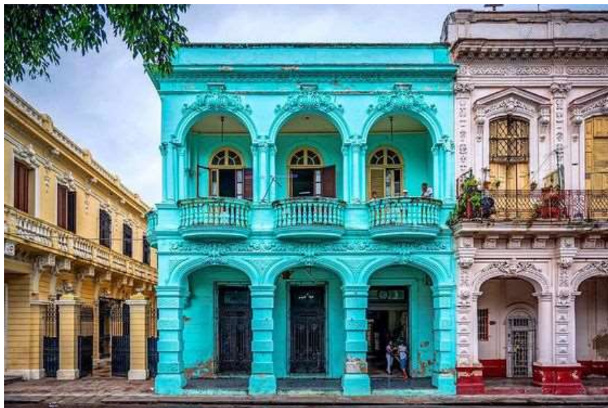
Viviendas rehabilitadas en el Paseo del Prado, denominado Paseo Martí desde 1904. Obsérvese los característicos portales corridos en la composición de las fachadas de las viviendas habaneras que ofrecen confort y protección al caminante. Imagen recuperada el 08.09.2020 desde https://bit.ly/2FtNjMi
