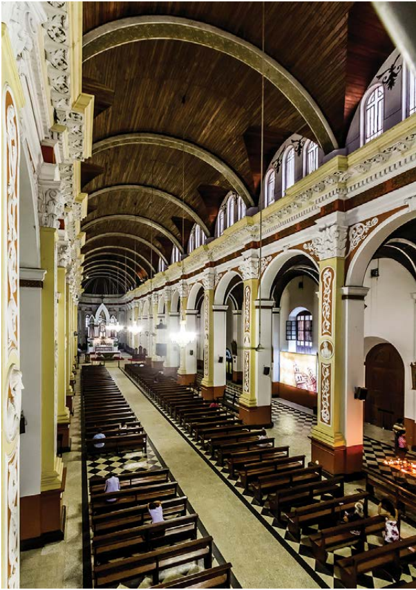
5. Bóvedas madereras o falsas: de cañón con lunetos en la nave central, a la izquierda; de aristas en una nave lateral, a la derecha. Nótese la gran cornisa a nivel de imposta. (Fotos: Álvaro Mier , 2015)
