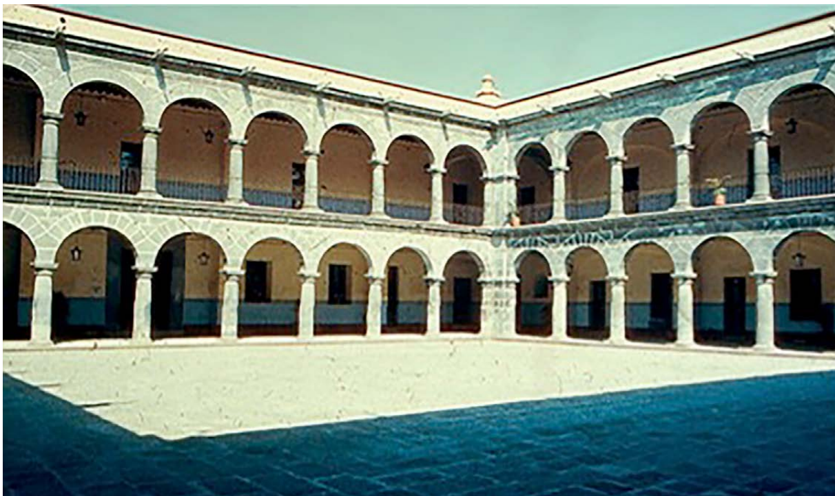
Vista del patio principal liberado con la danza de arcos del ex Real Hospital de San Pedro. Foto: José Antonio Terán Bonilla.
