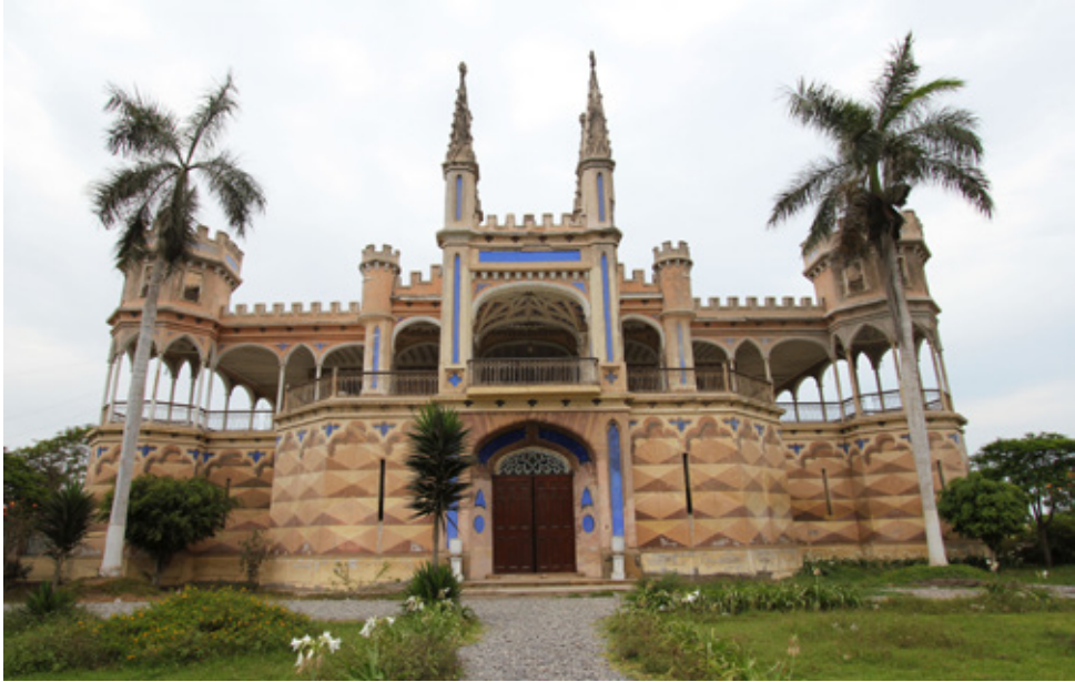
Frontispicio de la vivienda principal de la antigua hacienda Unanue. Imagen: propia, 2018.
