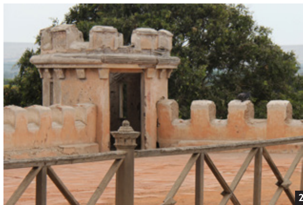
1. Traspatio con habitaciones de servicio. 2. Torreón sureste al que se accede desde la azotea del segundo nivel de la vivienda. Imágenes: propias, 2018.
