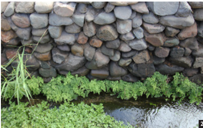
Nasca, acueducto abierto de Achaco. 1. Canal principal y “cangrejera” dispuesta perpendicularmente para aumentar la filtración de agua. 2. Muros laterales ligeramente inclinados hacia afuera y erigidos con cantos rodados. Imagen: propia, 2018.
