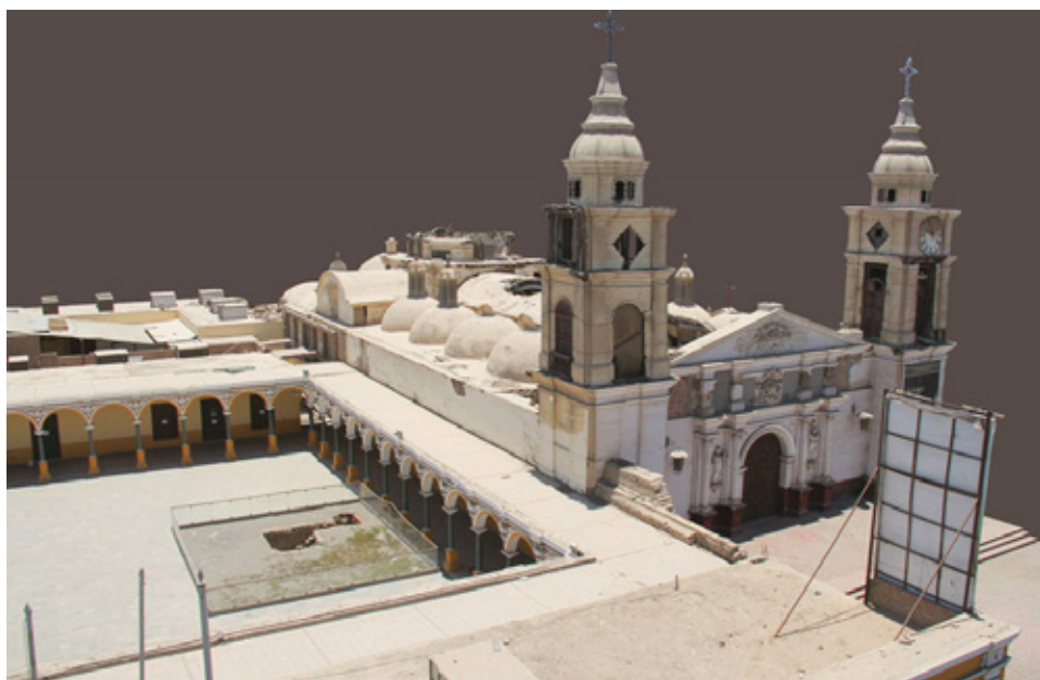
Perú, Ica. Antiguo colegio e iglesia de la Compañía de Jesús, estado actual. Imagen propia, 2017
