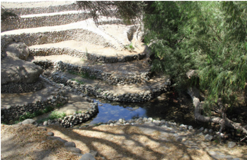
Nasca, acueducto de Ocongalla: se pueden observar las tres cangrejeras que forman la pequeña laguna desde la cual fluye el agua hacia la cocha a través de un canal abierto. Imagen: propia, 2018.
