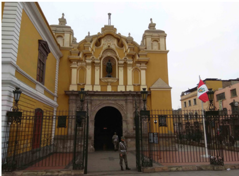
Fachada de principal del Panteón de los Próceres. Imagen: propia, 2018.
