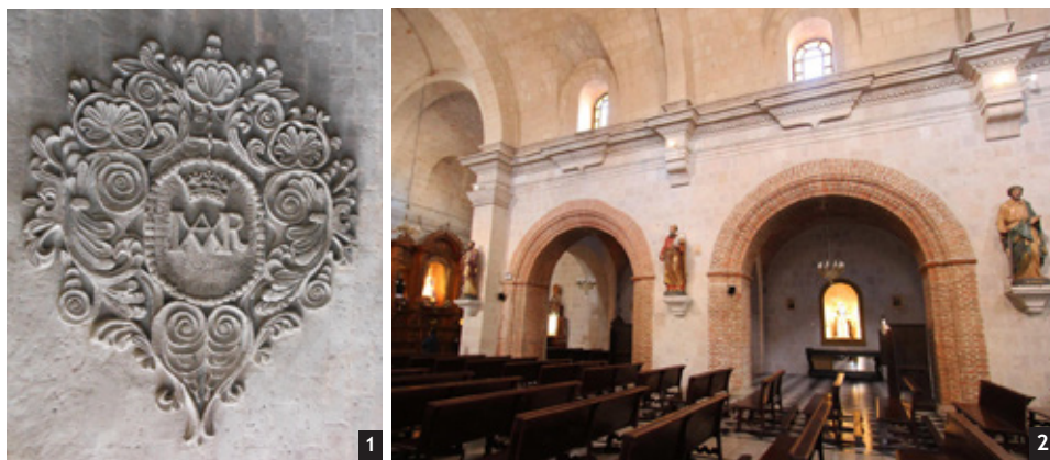
Arequipa, iglesia de Santo Domingo. 1. Detalle de la tarja con escusón, ubicada en el intradós de la bóveda del sotacoro, que data el templo como de 1677. Imagen: Samuel Amorós, 2016. 2. Arcos formeros de medio punto solucionados con ladrillos que separan la nave central de las laterales. El entablamento presenta la cornisa con un diseño limeño dieciochesco, el mismo que se refuerza con la presencia ménsulas en voladizo debajo de cada luneto. Imagen: propia, 2015.
