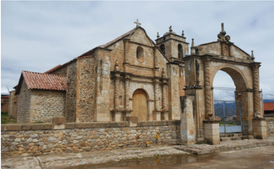
Apurímac, iglesia de Nuestra Señora de Copacabana de Ayrihuanca, con un atrio envolvente y delimitado por un muro pretil con portada de acceso. Imagen: propia, 2016.
