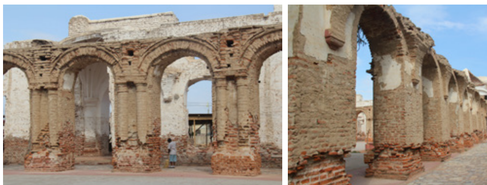
Patio del convento de San Agustín delimitado con galerías claustrales, las cuales en el frente orientado al patio presentan medias columnas de orden toscano adosadas a gruesos pilares rectangulares, mientras que en las elevaciones hacia las galerías son lisas, pudiéndose observar el arranque de las bóvedas de arista que cubrieron los tramos de la galería a partir de sotabancos en forma de ménsula. Imágenes: propias, 2017.
