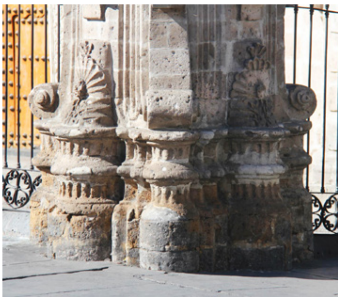
Pedestal del pilar esquinero, formado por cinco medias columnas adosadas a un polígono irregular. Imagen: propia, 2015.
