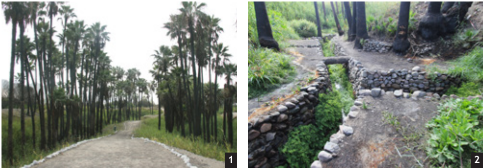
Nasca, acueducto de Achaco. 1. Vista general del palmeral a ambos lados de la senda que conduce al acueducto. 2. Acueducto de canal a cielo abierto con cangrejeras laterales. Imágenes: propias, 2018
