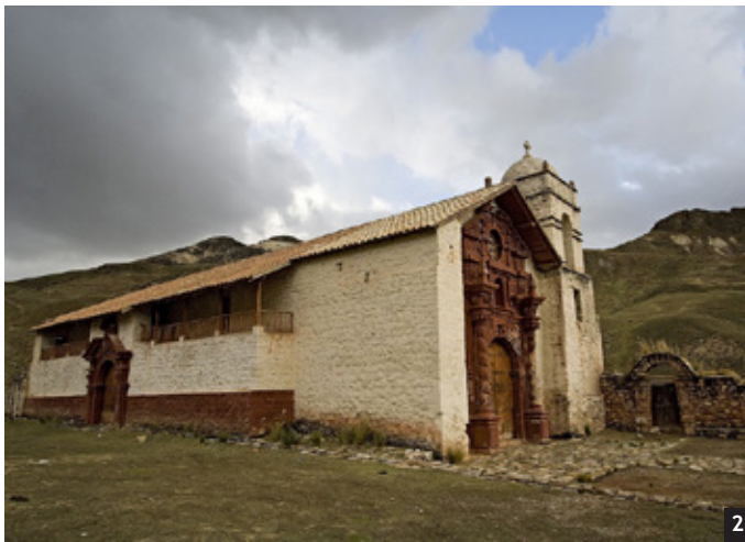
Capillas abiertas en forma de logias. 1. Cusco, iglesia de San Jerónimo, capilla abierta a los pies del templo y frontal al atrio delantero. 2. Huancavelica, iglesia de Santa Bárbara, capilla abierta sobre el muro del Evangelio y vinculada al atrio lateral. Imágenes: propias, 2004 y 2002.
