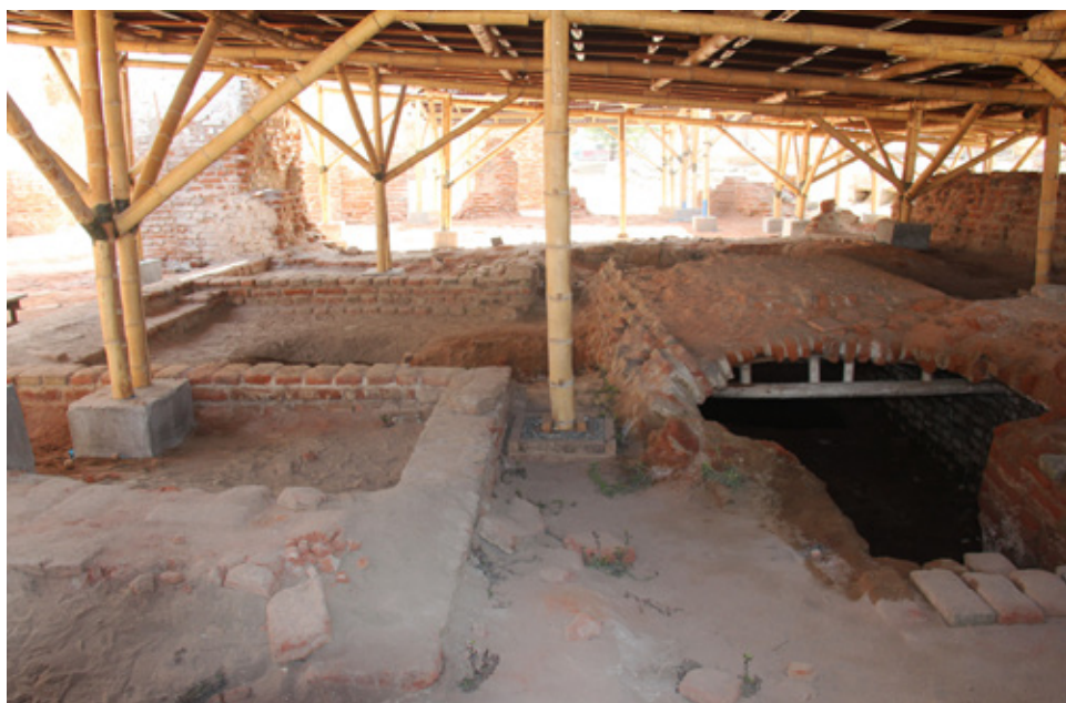
Iglesia de San Agustín de Saña: sector del presbiterio mostrando la cripta sepulcral principal techada con bóveda de medio cañón corrido de ladrillos, generada por un arco escarzano. Se requirieron siete escalones desde la nave para acceder al nivel del presbiterio en el sector del altar y retablo mayor. Imagen: propia, 2015.
