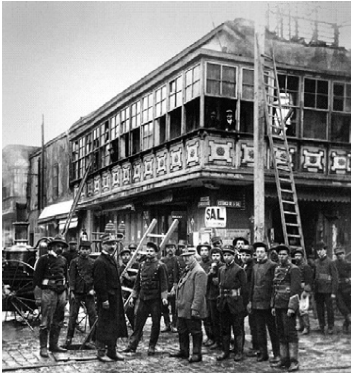
Dstrucción de los balcones por acción del fuego. Balcón en la esquina de los jirones Camaná e Ica (hoy inexistente) Imagen: Los incendios en Lima de antaño https://bit.ly/2VGyXe4 [Consulta: 24.03.2019]
