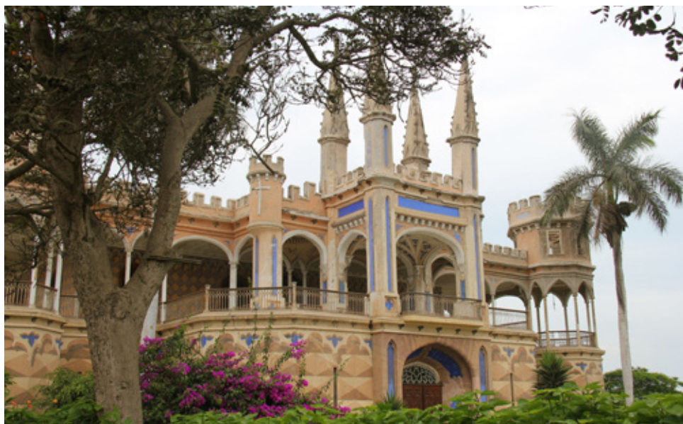
Extraordinaria arquitectura rural del siglo XIX en la campiña cañetana, resuelta con técnicas constructivas propias del siglo XVIII y un lenguaje arquitectónico y pictórico propio del neogótico. Imagen: propia, 2018.
