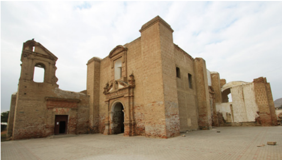
Iglesia de San Agustín de Saña, estado actual. El muro de pies ostenta una portada asimétrica de dos cuerpos. En compás se sitúa la portada de la anteportería y en el muro esquinero fue erigida una espadaña que ocupa el ángulo. Imagen: propia, 2015.
